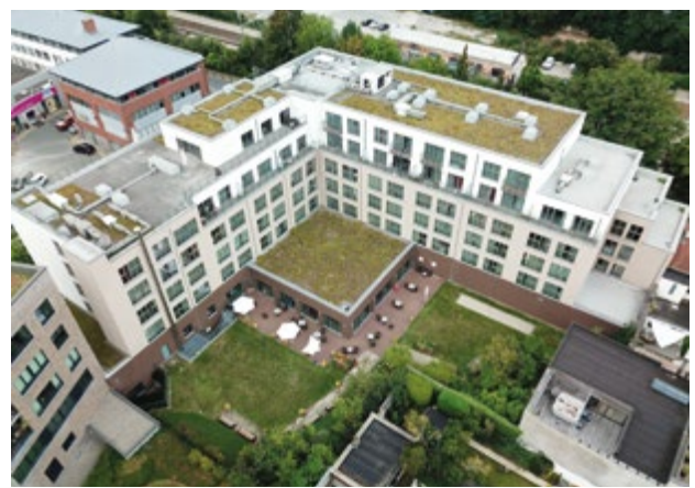
Uccle, Bruxelles (Belgique), Maison de repos et de soins Toitures végétalisées
